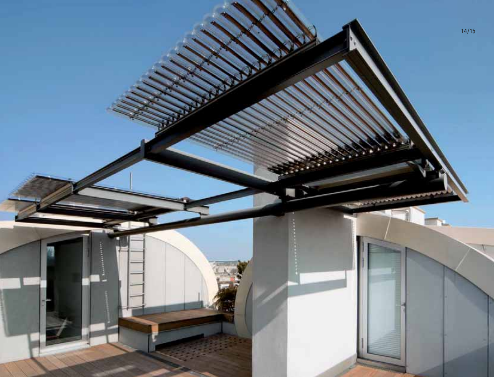
Příklad použití zařízení Vitosol 200-T – trubicové kolektory na vodorovné konstrukci.
